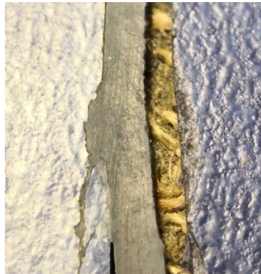
Ranurado por mal corte
