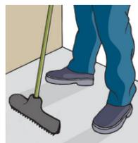
e. Despeje o produto no contrapiso e ajude a regularização com uma desempenadeira dentada ou rodo com lâmina dentada na espessura desejada.
