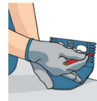
**a.** Com o auxílio de uma régua de metal ou do marcador de rodapé, trace na parede a altura do rodapé prevista em projeto.
