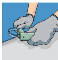
Devido ao processo de armazenamento vertical, as bordas das mantas sofrem naturalmente pequenos danos, como amassamentos ou impregnação de sujeira. Por isso, devem ser refiladas em pelo menos 1cm para melhorar a segurança da solda (fria ou quente). Este processo pode ser feito com um corta bordas ou com estilete, auxiliado por uma régua de metal.
