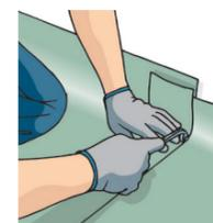
**18.1.2.** A fresa manual com lâmina "U" pode ser utilizada em locais de difícil acesso como paredes, rodapés ou no piso próximo à parede.
