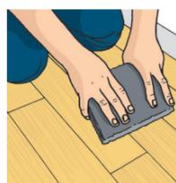
**25.7.** Ao finalizar, pressione as régulas com uma régua de madeira revestida com carpete ou rolo compressor de 50kg para que fiquem bem aderidas ao contrapiso.
