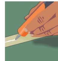
**19.3.** Insira o bico aplicador, aperte a bisnaga de Selanfix® e aplique a solda, mantendo uma velocidade constante. Se houver uma falha, aplique o produto somente neste local.
